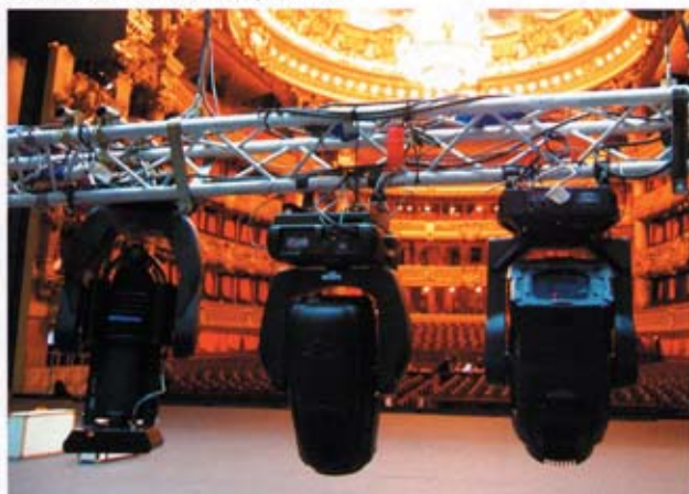
Vue de projecteurs asservis sur le plateau de l'Opéra Garnier - Photo © Philippe Warrant
